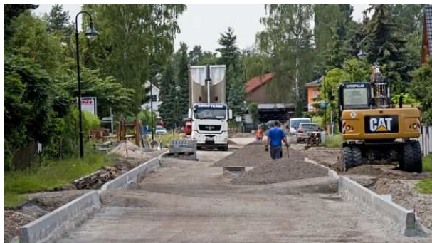
Baustelle der Ortsdurchfahrt im brandenburgischen Zepernick (Juli 2011) | © Robert Schlesinger/dpa
